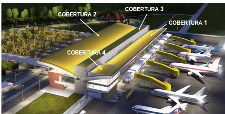
Figura 3 - Identificação das coberturas 01 a 04 - TPS
