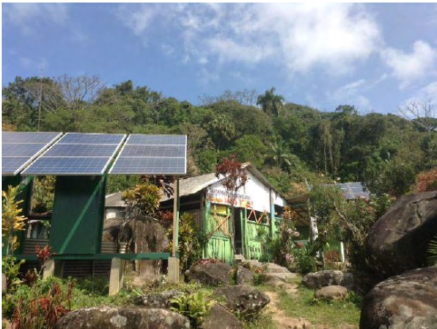
Figura 75: Sistema FV Isolado em Minirede em Guaraqueçaba [50] .
