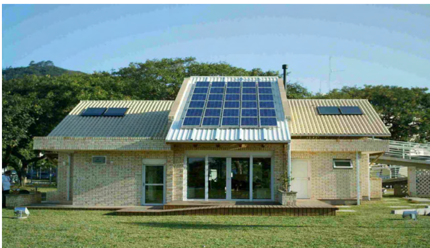
Figura 13: Sistemas fotovoltaicos conectados à rede elétrica aplicados às edificações [19] .
