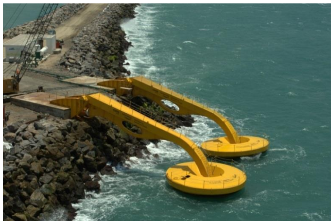
Figura 13 Usina de ondas do PECÉM
