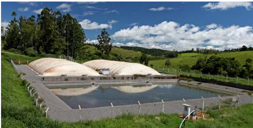
Figura 41 Biodigestor modelo canadense com lagoa de efluentes
