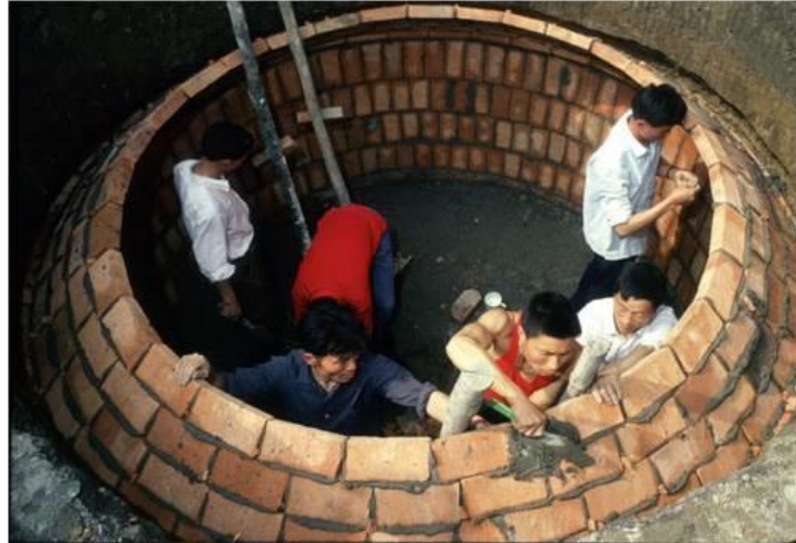
Figura 37 Operários concluindo a construção de um biodigestor modelo chinês
