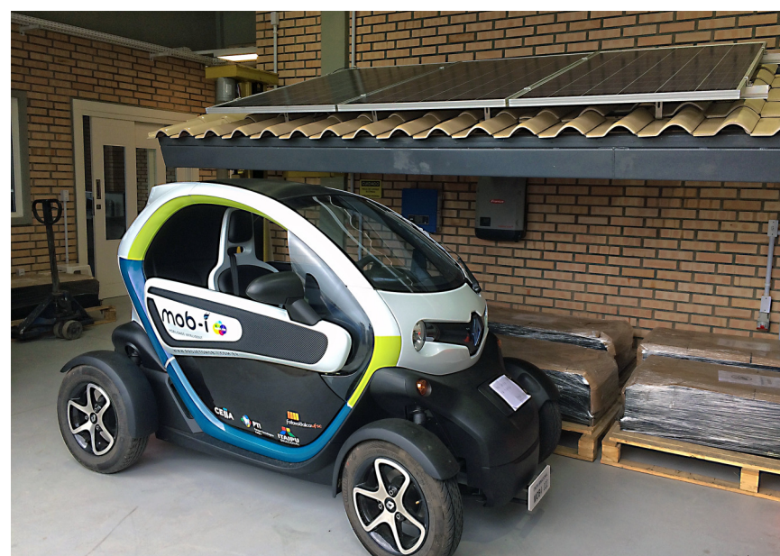
Figura 63. Veículo elétrico de pequeno porte estacionado sob telhado solar fotovoltaico.
