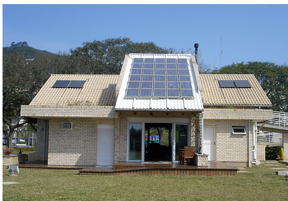
Figura 54. Casa Eficiente Eletrosul em Florianópolis-SC, com um gerador solar fotovoltaico de 2 kWp integrado em seção do telhado orientado para o norte verdadeiro e inclinado a 27 graus (equivalente à latitude de Florianópolis).
