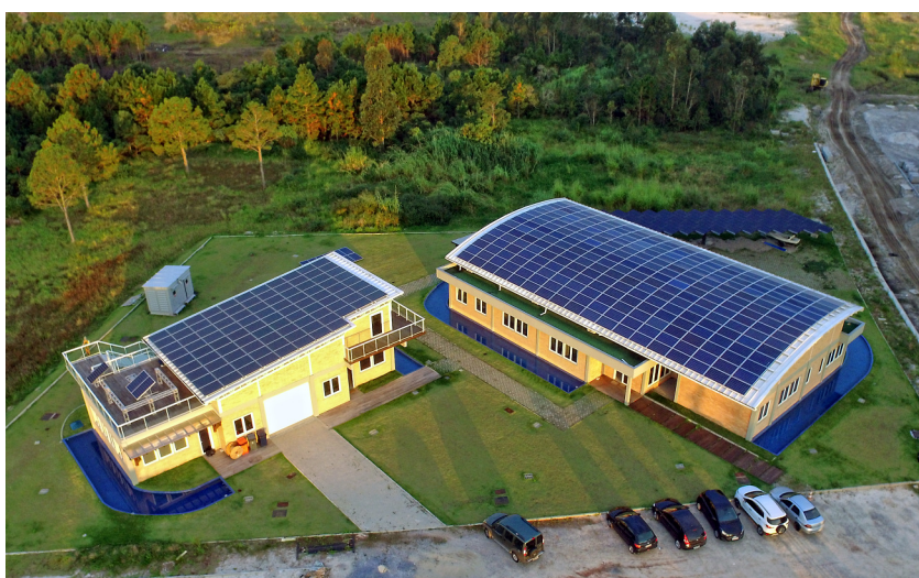
Figura 55. Centro de Pesquisa e Capacitação em Energia Solar Fotovoltaica da Universidade Federal de Santa Catarina em Florianópolis-SC, com 100 kWp de geradores solares fotovoltaicos integrados nas coberturas dos prédios e também do estacionamento.
