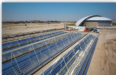
Figura 51. Campo de coletores concentradores de uma instalação de refrigeração solar em uma arena esportiva em Doha, Qatar (Zahler et al., 2011).
