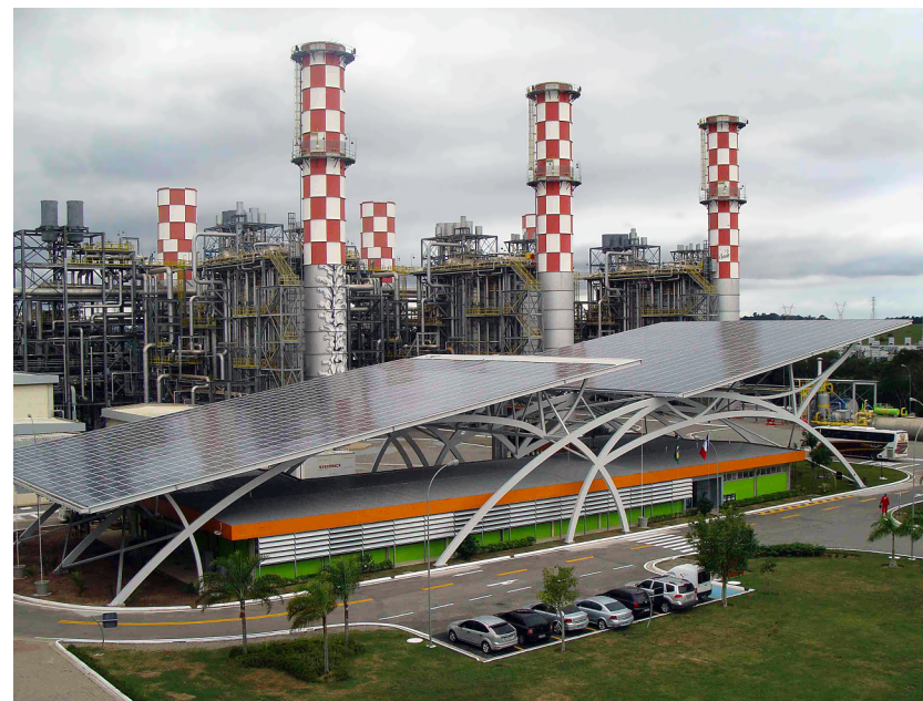
Figura 57. Integração de gerador solar fotovoltaico sobre a edificação administrativa da Usina Termoelétrica a Gás EDF Norte Fluminense, em Macaé-RJ, com 320 kWp de potência.
