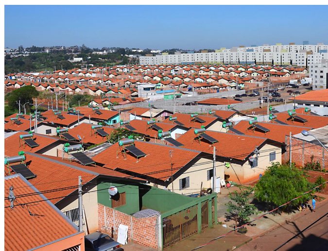
Figura 43. Vista das unidades habitacionais unifamiliares do Residencial Vista Bela (Londrina – PR) com sistemas de aquecimento solar compactos instalados (cortesia: Thalita Giglio).
