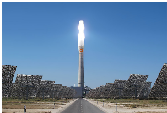
Figura 50. Usina heliotérmica com torre central Gemasolar, Espanha (Burgaleta et al., 2011).
