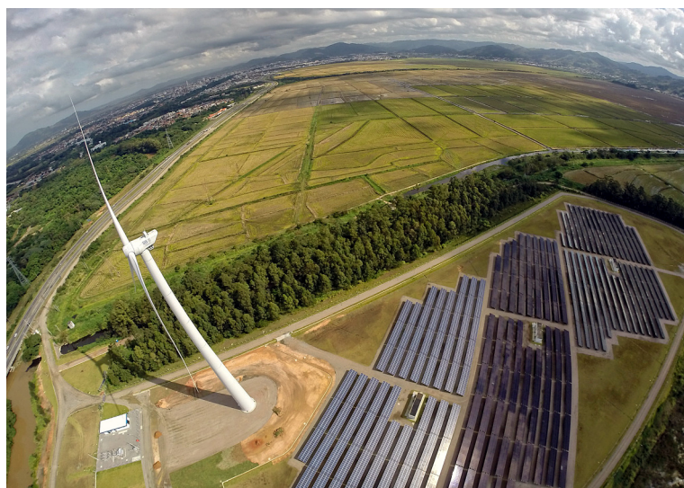
Figura 58. Usina Solar Fotovoltaica Cidade Azul em Tubarão-SC, com potência instalada de 3 MWp e utilizando três tecnologias fotovoltaicas distintas.
