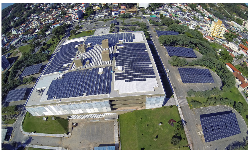
Figura 56. Edifício Sede da Eletrosul em Florianópolis-SC, com geradores solares fotovoltaicos integrados na cobertura do prédio e nos estacionamentos, somando 1 MWp de potência.
